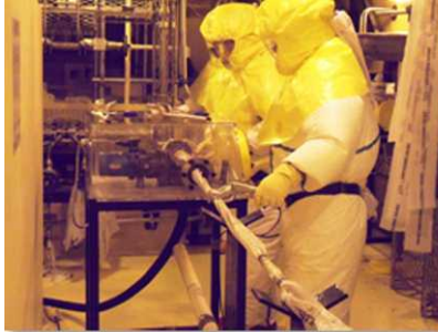
グローブボックス内での古いヒーターの切断
