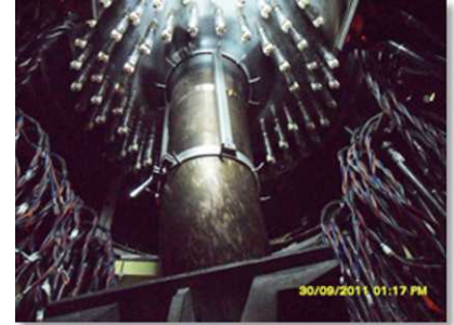
新しいヒーターを設置した加圧器
