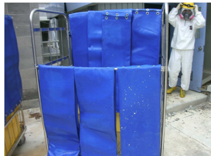
図6：2号機での遮へい壁の設置
