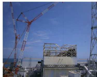
図9：1号機のクレーン作業
