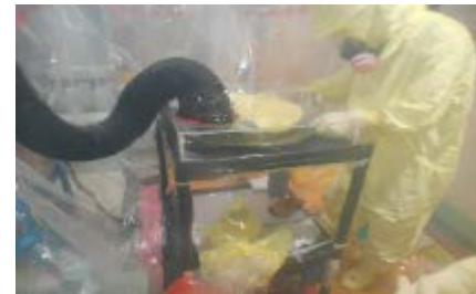
(다카하마 3·4호기 손질작업)
