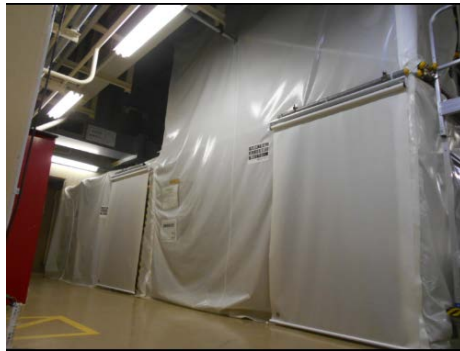
放射線管理用資機材置場 (不燃シートで作製)
